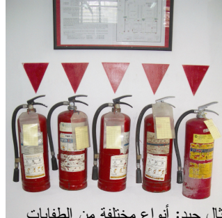
مثال جيد: أنواع مختلفة من الطفايات متوفرة ومعلق عليها كارت الصيانة
